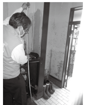
床上浸水の調査の様子
