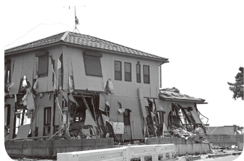
地震による住宅の損壊
